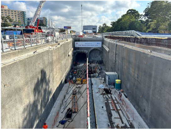
Figure 2.5: Clyde Dive site – Dive Concrete base pour
